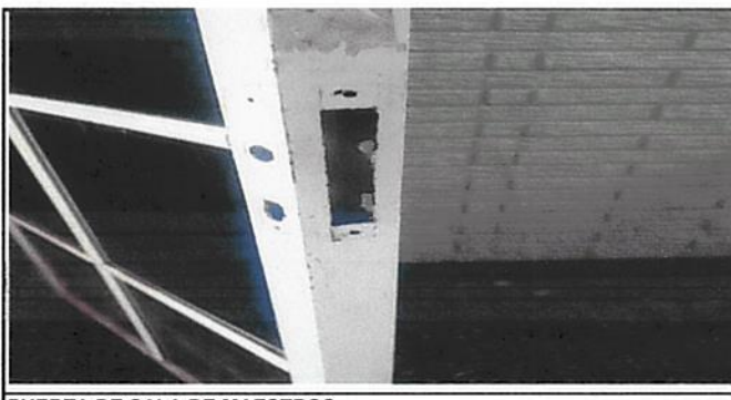
PUERTA DE SALA DE MAESTROS
