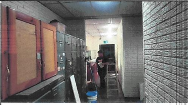
PINTURA DE PASILLO DE CONTABILIDAD
